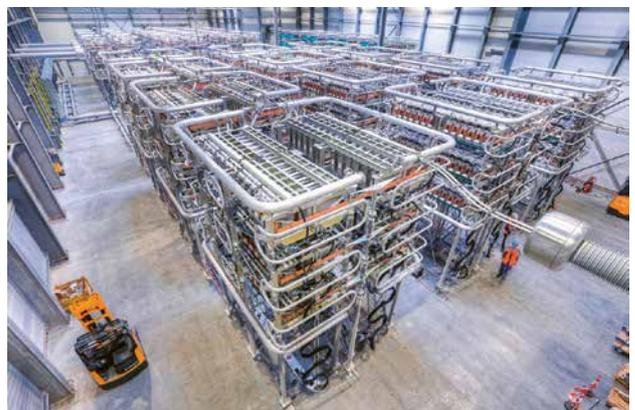
Die Konverterhalle ist das Kernelement der Konverterstation. Hier wird Wechsel- in Gleichstrom umgewandelt und umgekehrt.
